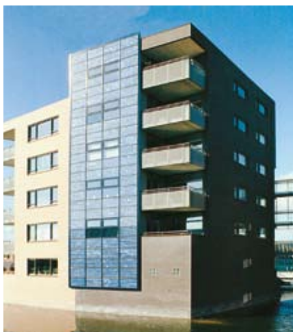
Woongebouw met zonnepanelen aan de gevel (Nieuwland, Amersfoort)
