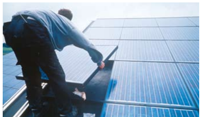
Montage van de zonnepanelen in Langedijk
