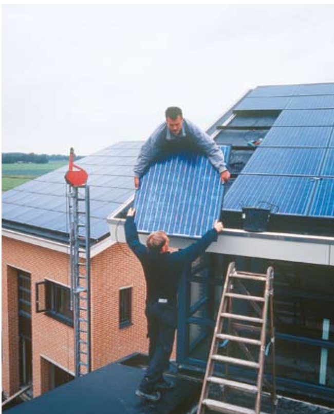
Montage van de zonnepanelen in Langedijk
