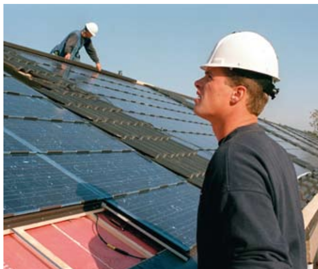
Montage van zonnepanelen
