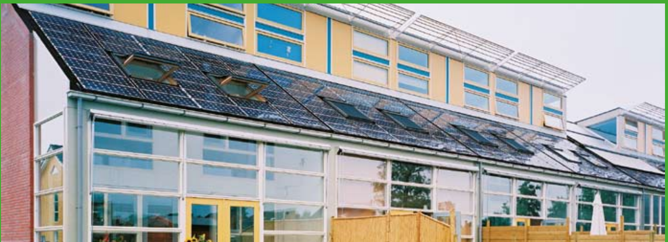
Een geïntegreerd zonnestroomsysteem dat deel uit maakt van een pakket aan energiemaatregelen (Havankpark, Leeuwarden).
