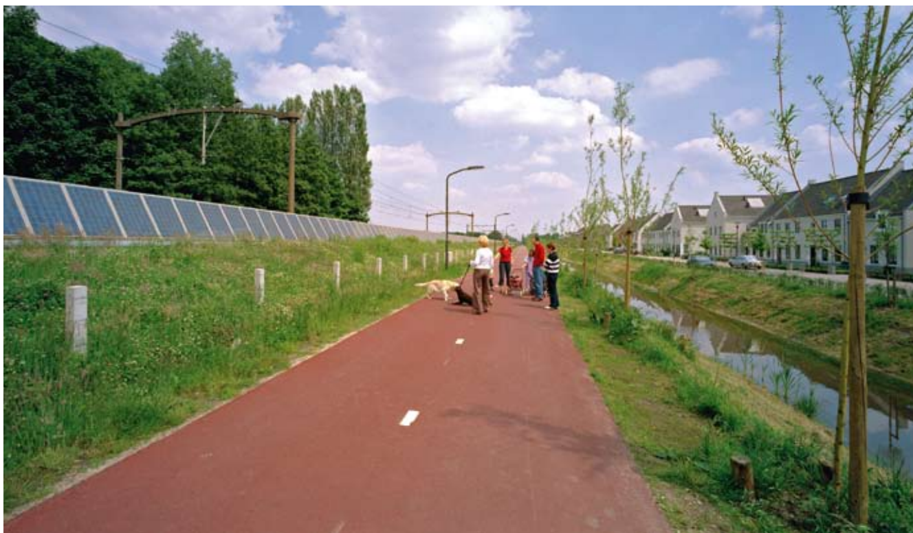
Geluidsscherm met zonnepanelen bij Helmond Brandevoort
