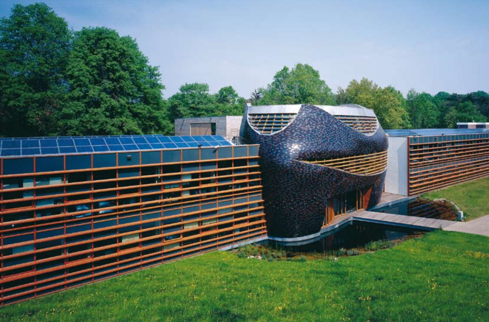
Kantoor WNF, Zeist. Naast veel energiemaatregelen zijn er zonnepanelen op het dak geplaatst.
