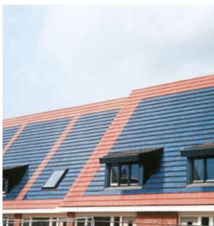
Barendrecht, Riederhoek: zonnepanelen worden als dakpannen gelegd.
