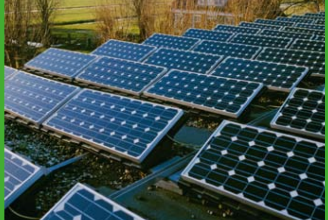
Rijen zonnepanelen op kunststof draagelementen op een plat dak
