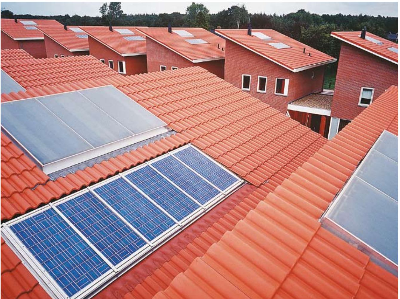
Zonnepanelen, geïntegreerd tussen de pannen, in combinatie met zonnecollector (Almelo)
