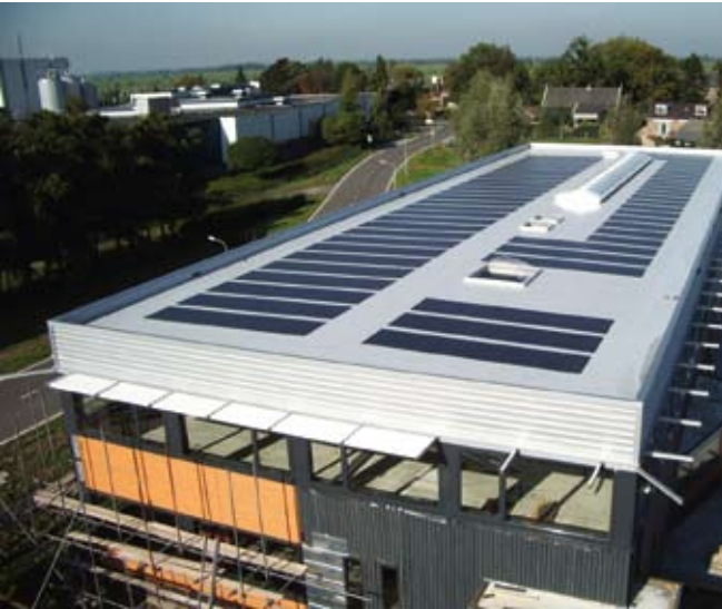
Dak met flexibele dakbedekking en PV, Bleskensgraaf
