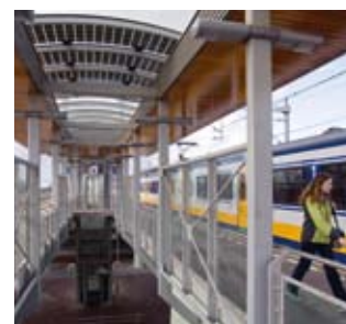
Station Utrecht Zuilen: halfronde doorzichtpanelen in overkapping
