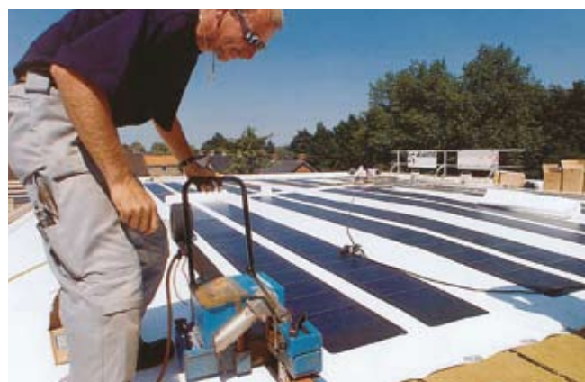
Flexibel dakbedekkingsmateriaal met zonnecellen
