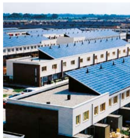
Nieuwland, Amersfoort: integratie in lessenaarsdaken
