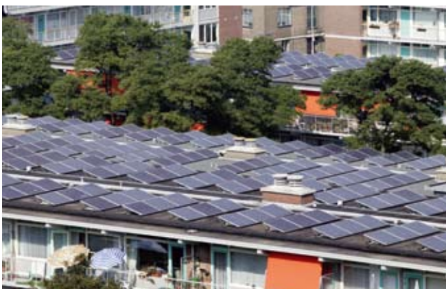
Flats met zonnestroomsystemen, Vestia, Den Haag
