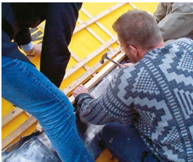
Aanbrengen van de bevestigingsprofielen door Van Erk, Krimpen a/d IJssel
