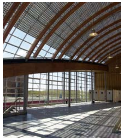
Atrium met lichtdoorlatende zonnepanelen (ECN, Petten)
